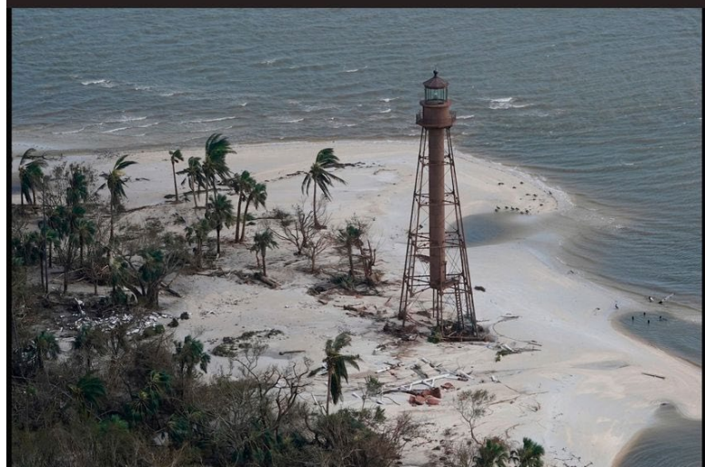
Efectos de un reciente huracán en Sanibel, Florida
